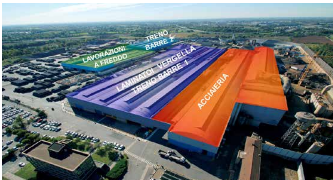
Vista di Alfa Acciai indicante la dislocazione delle 3 unità produttive e degli uffici
