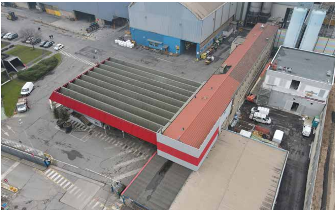
Lavori per la costruzione dell'impianto recupero calore
