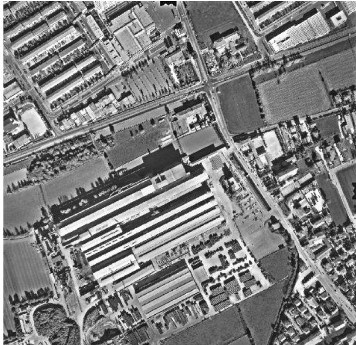
Dettaglio dello stabilimento nel 1995
