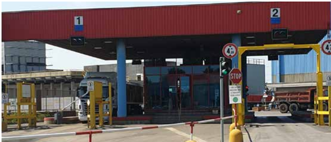
Ingresso-pesa con portale per il controllo radioattività
